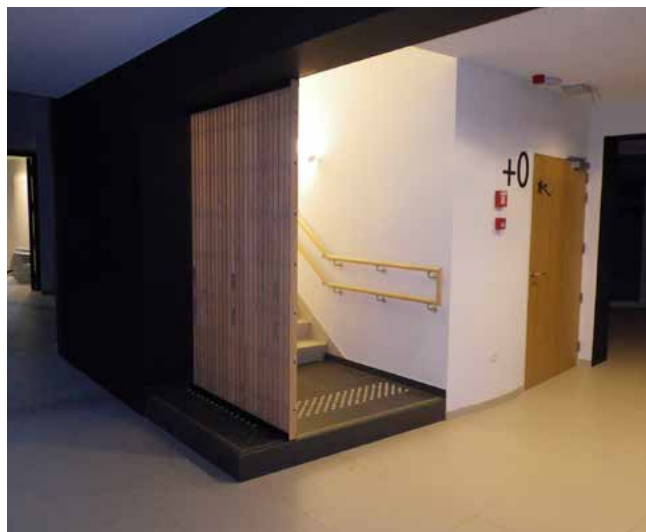
Fotografija: Stepene su opremljene dvostrukim neprekidnim rukohvatom i odgovarajućim osvetljenjem. Kontrastne boje i taktilna obeležja privlače pažnju na stepenice. (© TGB, 2013)
