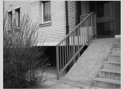
Rampa na Novom Beogradu
