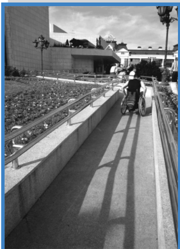
Rampa je suviše duga i strma na određenim mestima i teška za korišćenje bez tuđe pomoći
